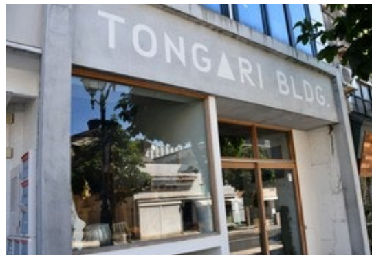
【図 A-2-2】 とんがりビル
